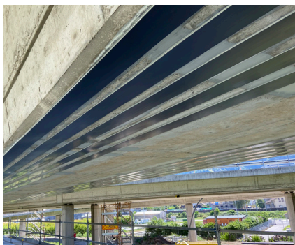
Momentforstærkning med eksternt pålimet S&P C-laminate
