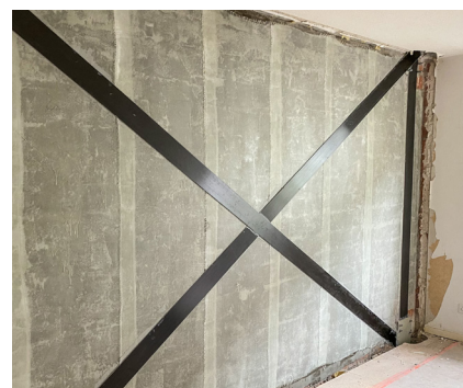
Stabilitetsforstærkning med S&P G-Sheet og S&P C-Laminate
