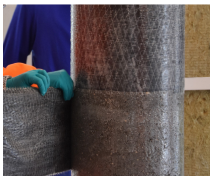
Søjletryksforstærkning med S&P C-Sheet 240
