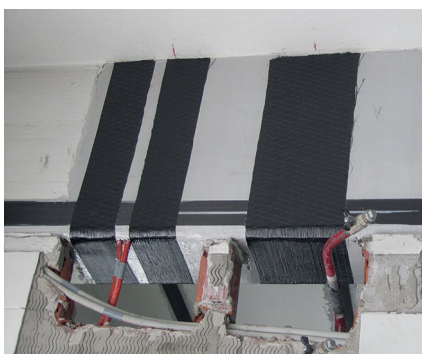
Forskydningsforstærkning med S&P C-Sheet 640
