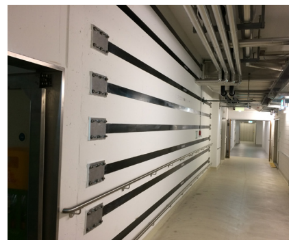
Forskydningsforstærkning med forspændt S&P C-Laminate
