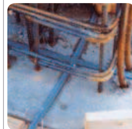
Eks. på tætning på Hydrotite® mellem pladsstøbt bundplade og væg.
